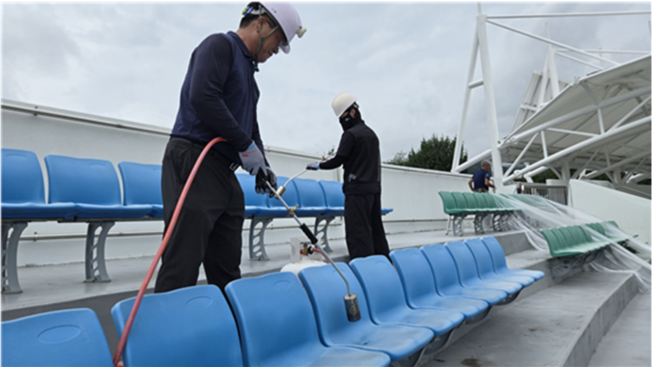
▲ 평창군시설관리공단 직원들이 평창종합운동장의 노후 관람석을 'LP가스 토치 원색 복원 공법'으로 복원하는 모습. ©평창군시설관리공단
